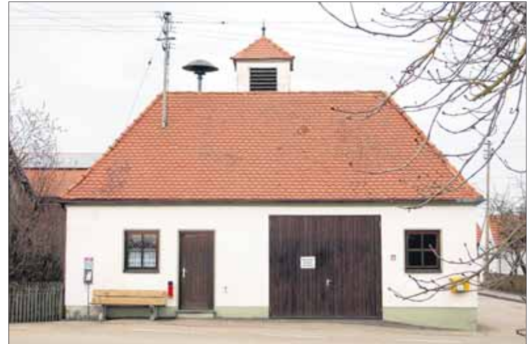
Das aus dem Jahr 1952 erstellte Feuerwehraus der Freiwilligen Feuerwehr Rieblingen entspricht für das neue Fahrzeug nicht mehr den Anforderungen und muss umgebaut werden. Fotos: Friedrich
