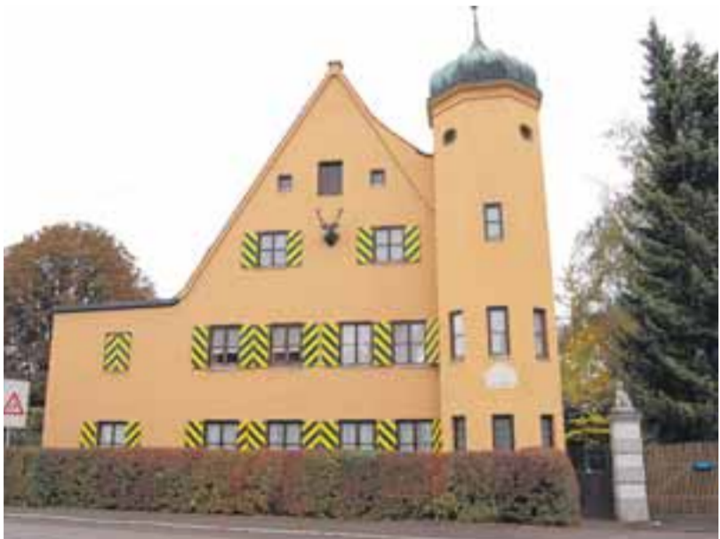
In Laugna sollen zwischen der Kirche und dem früheren Forstamt (Foto) entlang der Straße künftig Parkplätze und ein Gehweg entstehen.
