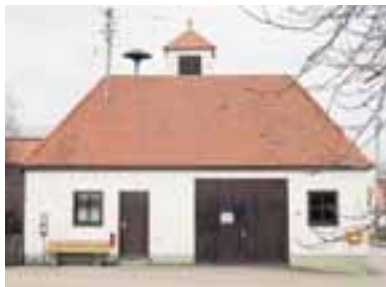
Das aus dem Jahr 1952 stammende Feuerwehrhaus in Rieblingen entspricht für das neue Fahrzeug nicht mehr den Anforderungen und muss erweitert werden.
